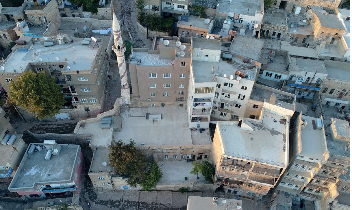
Resim 2 Şeyh Şeyhullah Camii. Hava Fotoğrafi [Zahit Mungan tarafından çekilmiştir, 2017].
