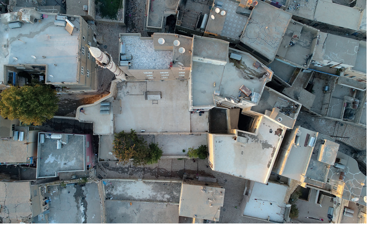
Resim 1: Şeyh Şeyhullah Camii. Hava Fotoğrafi [Zahit Mungan tarafından çekilmiştir, 2017].
