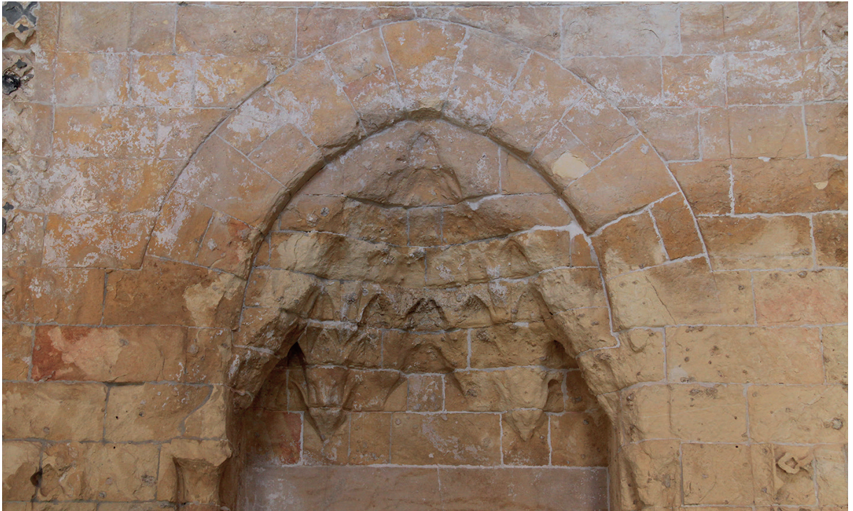
Resim 35 Kasımiye Medresesi. Duvar Nişi Ayrıntısı, 2016.
