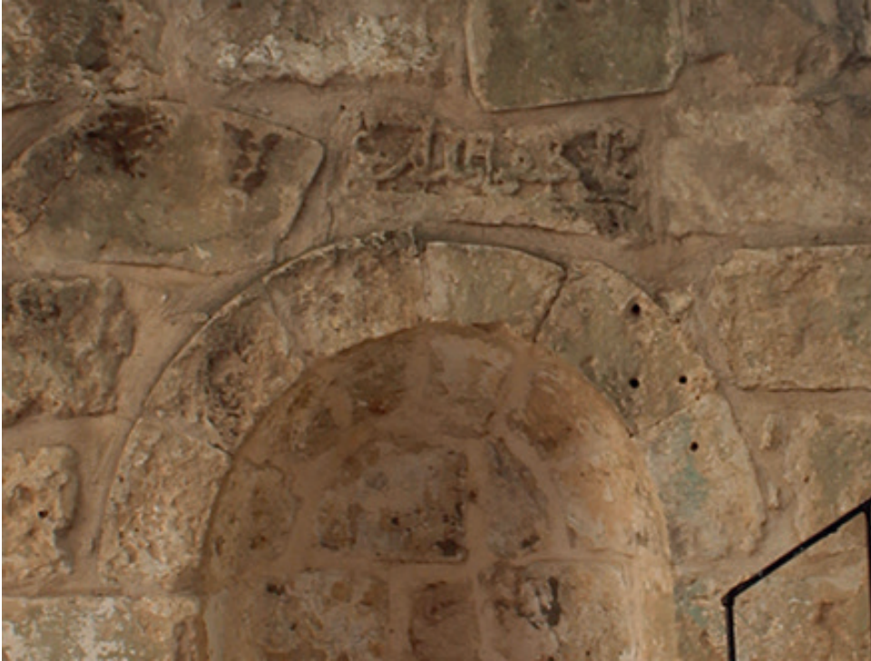
Resim 11 Şeyh Şeyhullah Camii. Avlu Güney Duvarında Namazgâh Mihrabı (batı) ve Devşirme Kitabeler.
