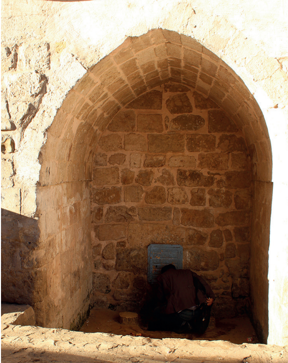
Resim 8 Şeyh Şeyhullah Camii. Mahalle Çeşmesi, 2017.
