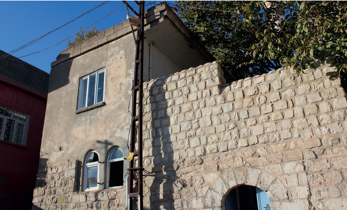
Resim 4 Şeyh Şeyhullah Camii. Avlu Güney Duvarı, Giriş Kapısı ve İmam Evi, 2016.
