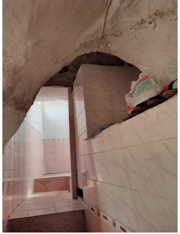
Resim 24 Şeyh Şeyhullah Camii. Islak Hacim Mekânları. Tonoğlu Mekân. Batıya Bakış, 2017.
