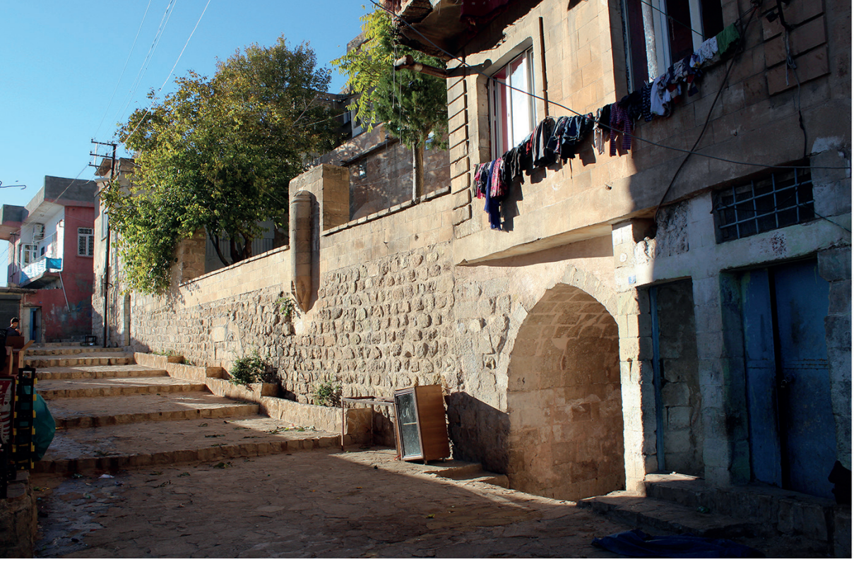
Resim 3 Şeyh Şeyhullah Camii. Avlu Güney Duvarı, Çeşme ve Namazgâh Mihrabı. Kuzey-batıya bakış, 2016.
