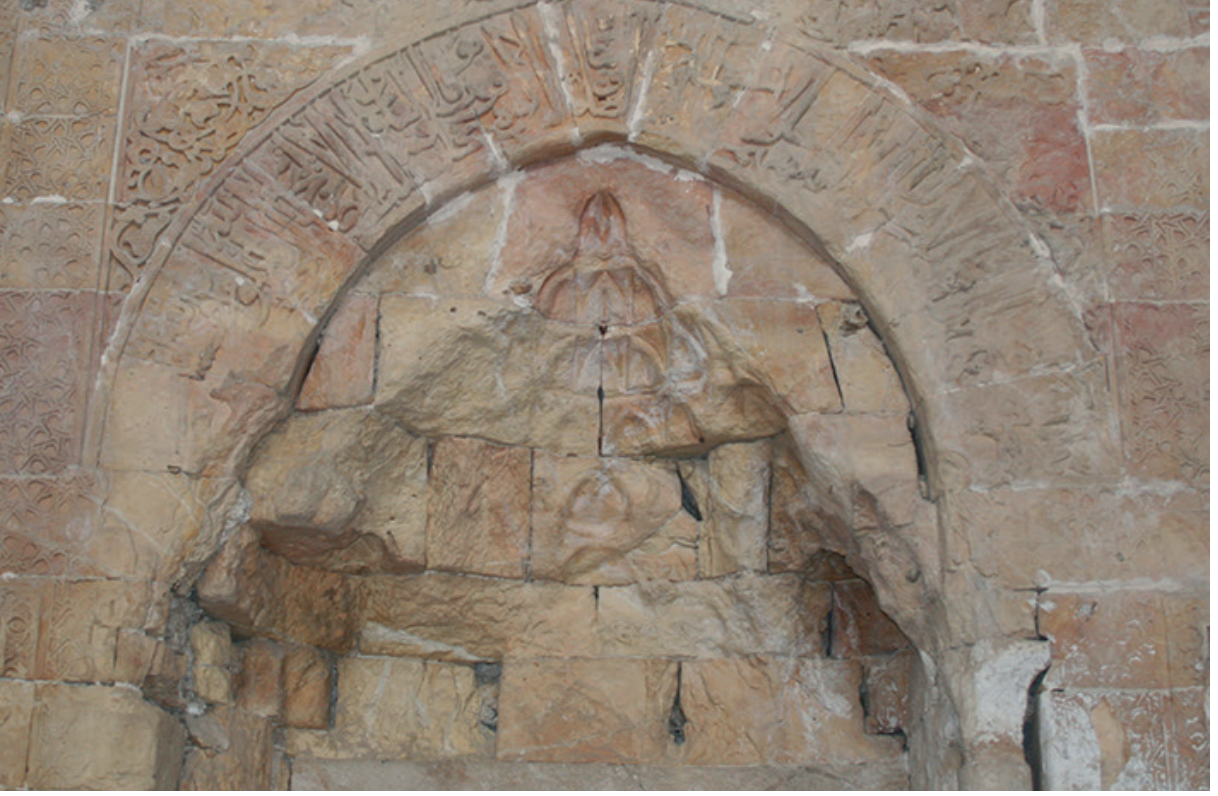
Resim 32 Zinciriye Medresesi, Mescid Giriş Kapısı. İçten Görünüş, 2016.
