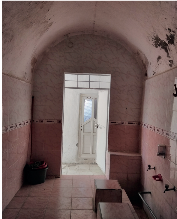
Resim 25 Şeyh Şeyhullah Camii. Islak Hacim Mekânları. Eyvanlı Giriş. Güneye Bakış, 2017.
