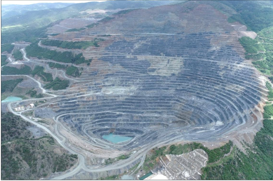
Şekil 3. Gökırmak Açık Ocak sahasının genel görünümü (kuzeyden güneye bakış) (General view of the Gökırmak Open Pit Mine (view from north to south))
