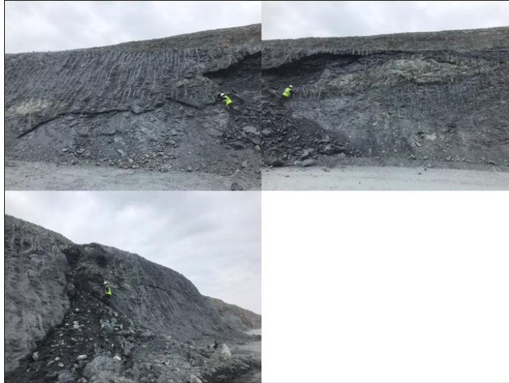
Şekil 11. Yatay kuyu açılmadan önce yüzeyde meydana gelen deformasyonlar (Deformations occurring on the surface before horizontal well drilling)
