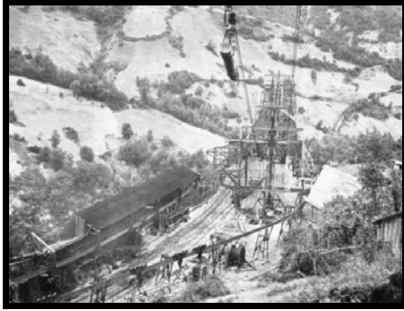
Fotoğraf 4: Yenice (84) havai hat istasyonu.
