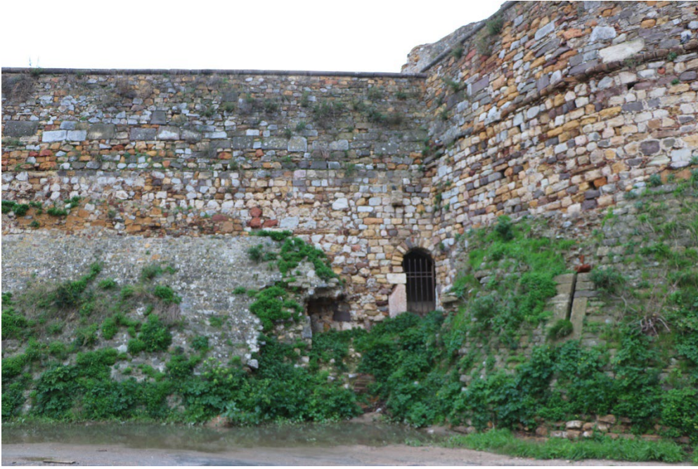
Foto.8. Batı cephe üzerindeki tahliye kapılarından.
