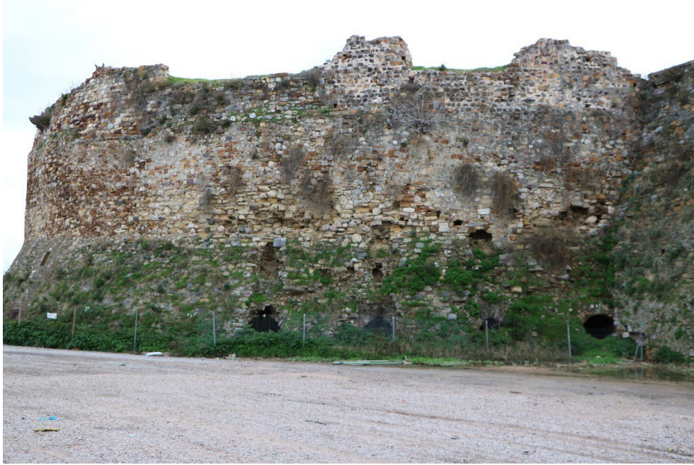
Foto. 9. Batı cephe üzerindeki tahliye kapılarından.
