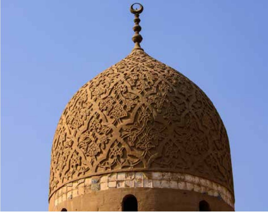
Resim 13a- Emir Süleyman Türbesi'ndeki Yazıt Kuşağının Bugünkü Hâli
