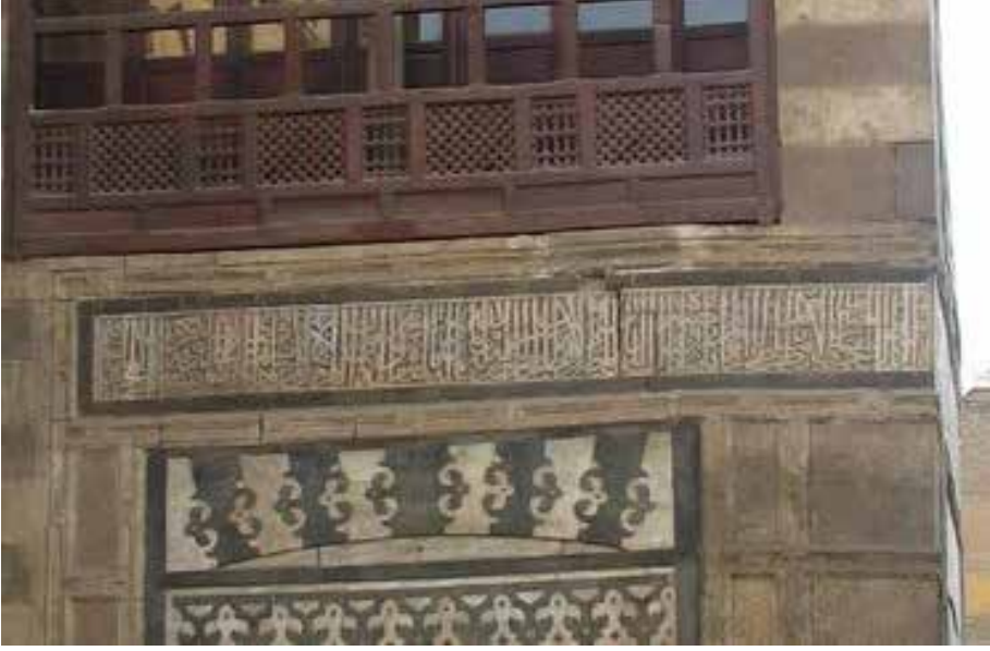
Resim 12a- Hüseyin Paşa Sebil-Kütüphanesi'nin Cephelerindeki Yazıt Kuşağının Sonu
