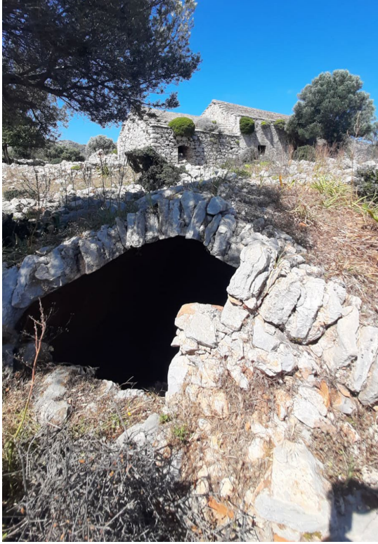
Şekil 8. Kilise yakınındaki sarnıç yapısı.
