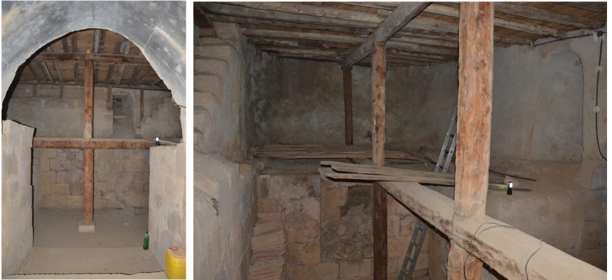
Şekil 6. Yapının -4.40 m kotuna ulaşımı sağlayan tonozlu bölüm ve 206 cm kot farkı
