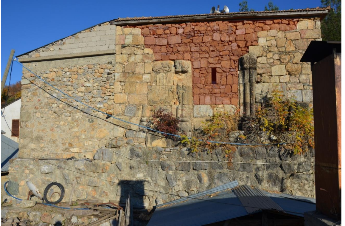
Şekil 10. Tarihsel süreç içerisinde beden duvarındaki özgün açıklıkların değiştiği düşünülen batı cephesi
