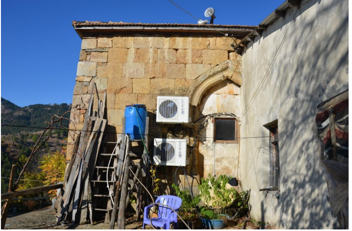
Şekil 9. Doğu beden duvarına bitişik ek yapı (imam evi)
