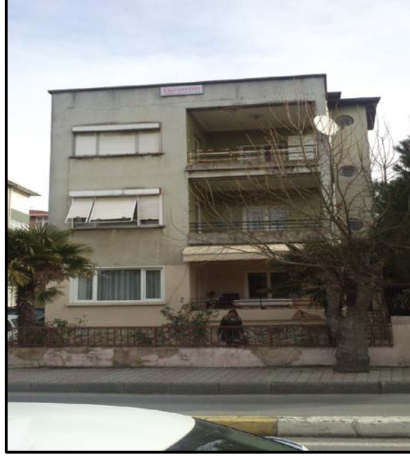
Şekil 1. İncelenen binanın önden görünüşü. Front view of the masonry building.
