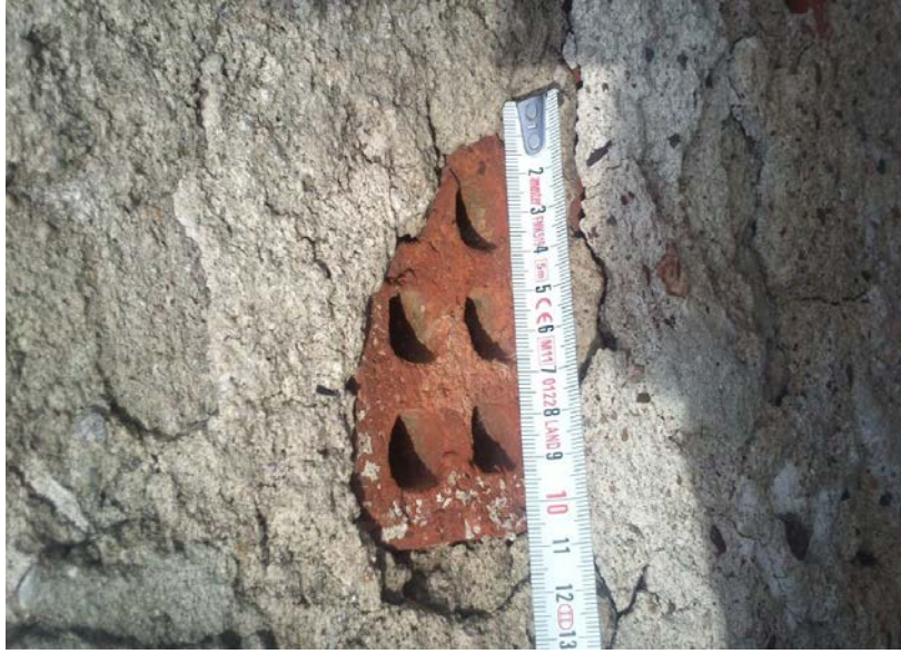
Şekil 5. Yapıda kullanılan taşıyıcı tuğla tipinin görüntüsü. 8. View of load-bearing brick in the masonry building.
