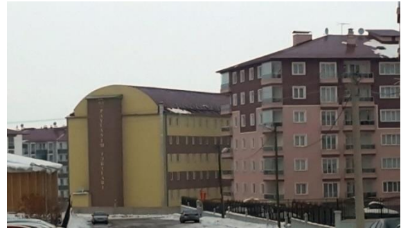
Resim 1-3. Çatı formu ve malzemesi çatıdaki karın tahliyesini birinci derecede etkilemektedir
