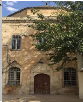
Batı Cephe Dış Görünüm.
