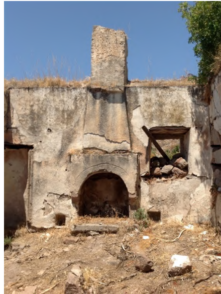
Resim 5: Batı kısa duvarı ve ocak yapısı
