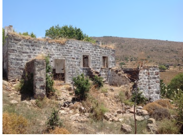
Resim 3: Güney uzun duvarı ve giriş kapısı
