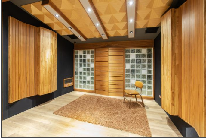
Şekil 12: Duvar yüzeylerinde emici ve yansıtıcı olarak değiştirilebilir panel kullanımı, Taichung-Tayvan (URL-10)
