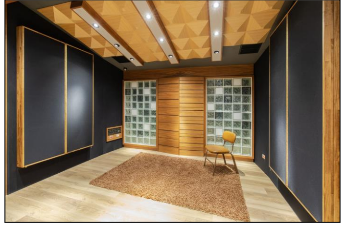
Şekil 12: Duvar yüzeylerinde emici ve yansıtıcı olarak değiştirilebilir panel kullanımı, Taichung-Tayvan (URL-10)
