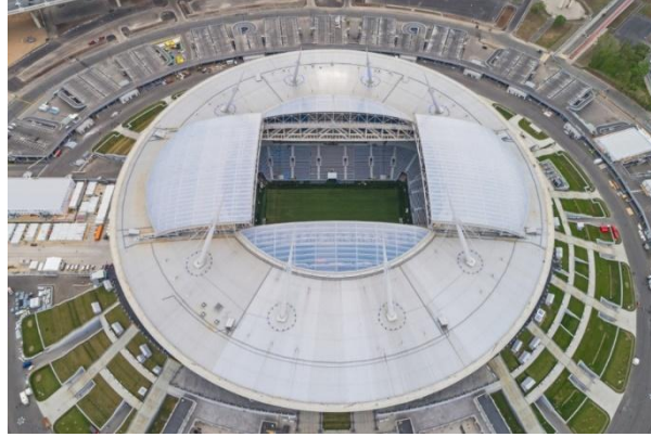
Şekil 6. Gazprom Arena Açılıp Kapanabilir Çatısı [28].
