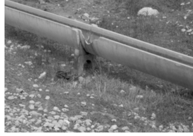
Şekil 14. Kanaletlerin kırılarak su alınması
