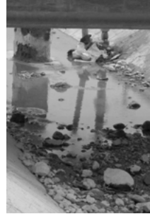
Şekil 20. Urfa ana kanalı içerisindeki taşlar ve diğer malzemeler
