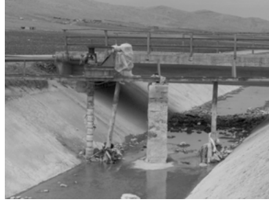
Şekil 17. Urfa ana kanalı üzerinde sistem dışı bir su alma yapısı
