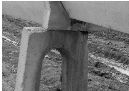
Şekil 16. Kanaletlerde sabit ayaklardaki kayma
