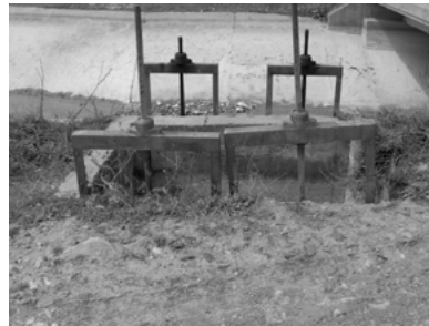
Şekil 11. Sorunlu bir sabit yüklü orifisli priz, Urfa ana kanalı
