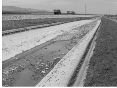
Şekil 19. Urfa ana kanalı içerisindeki taşlar ve kumlar
