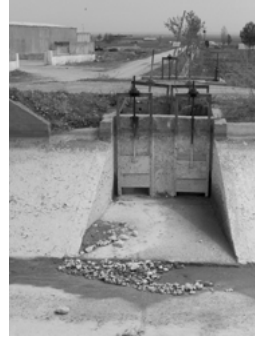
Şekil 12. Sorunlu bir sabit yüklü orifisli priz, Urfa ana kanalı
