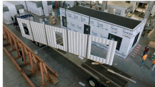
Şekil 9. Miselyum çekirdekli ve FRP kabuklu prefabrik cephe panelinin saha öncesi hazırlık aşamasındaki görünümü [URL 1]
