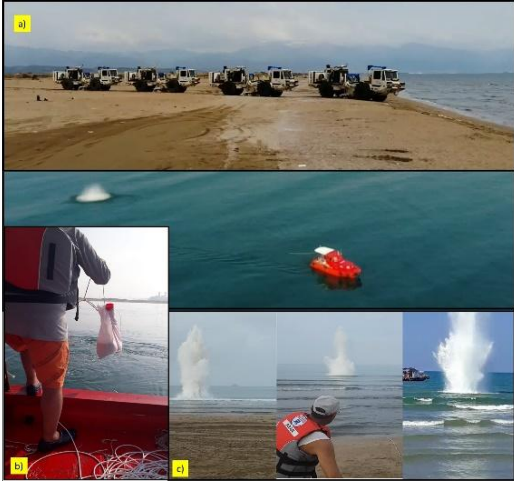
Şekil 12. Geçiş zonu hattının kara ve deniz kısmındaki çalışmalar; a) karada kullanılan kaynak: Vibratörler, b) Dinamitin denize indirilişi, c) denizde yapılan patlatmalar.
