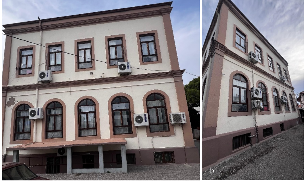
Resim 9: Yenikapı Dumlupınar Ortaokulu. Doğru cephesi (a), batı cephesi (b), (Yazarın Arşivi, 2024).
