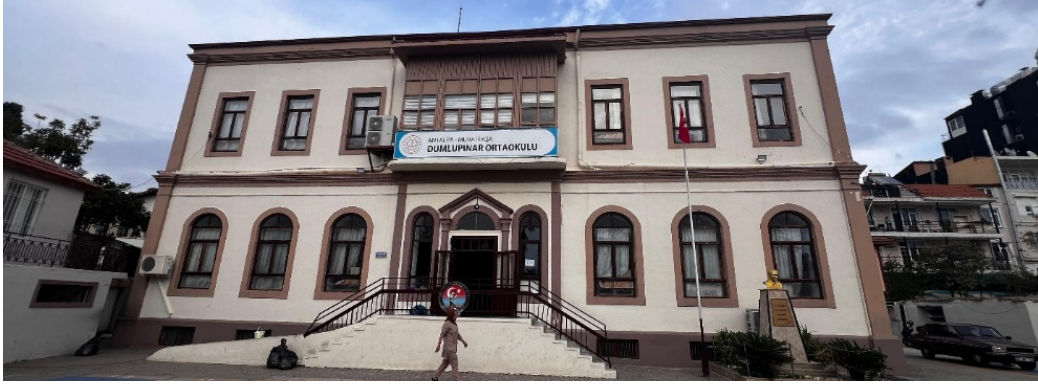
Resim 8 : Yenikapı Dumlupınar Ortaokulu okulun güney cephesi (Yazarın Arşivi, 2024)
