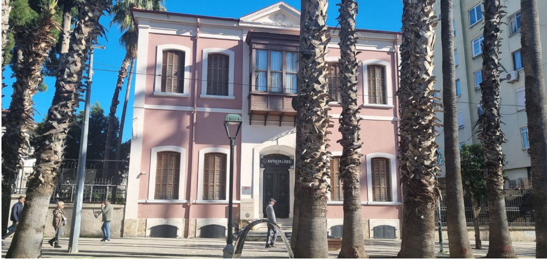
Resim 4 : Antalya Lisesi güney bina batı cephe (Yazarın Arşivi, 2024)
