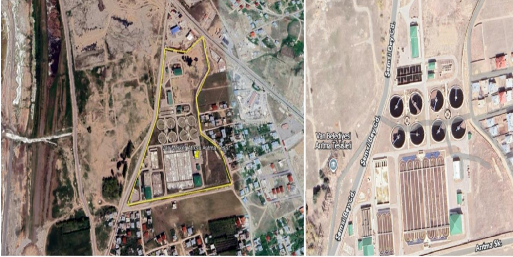
Şekil 1. Van merkez ileri biyolojik atık su arıtma tesisi (Google Earth).
