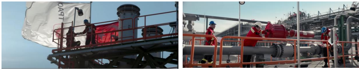
Şekil 5. Filyos Doğalgaz Tesisi ve işçilerin dayanışması (kesit 4)
