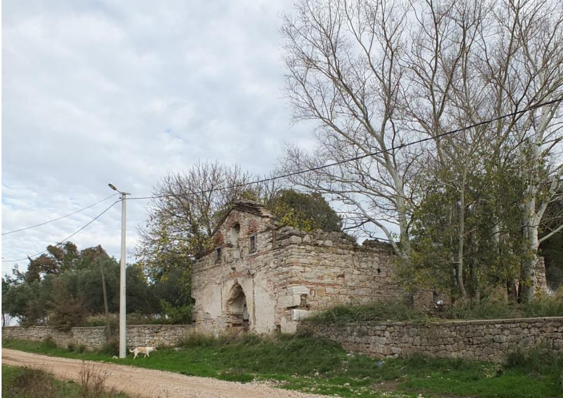
Şekil 6: Hagios Theodoros Kilisesi kuzeybatıdan genel görünüm
