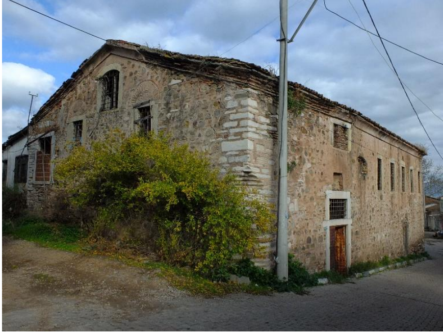
Şekil 2: Hagios Taxiarchoi Kilisesi güneybatıdan genel görünüm
