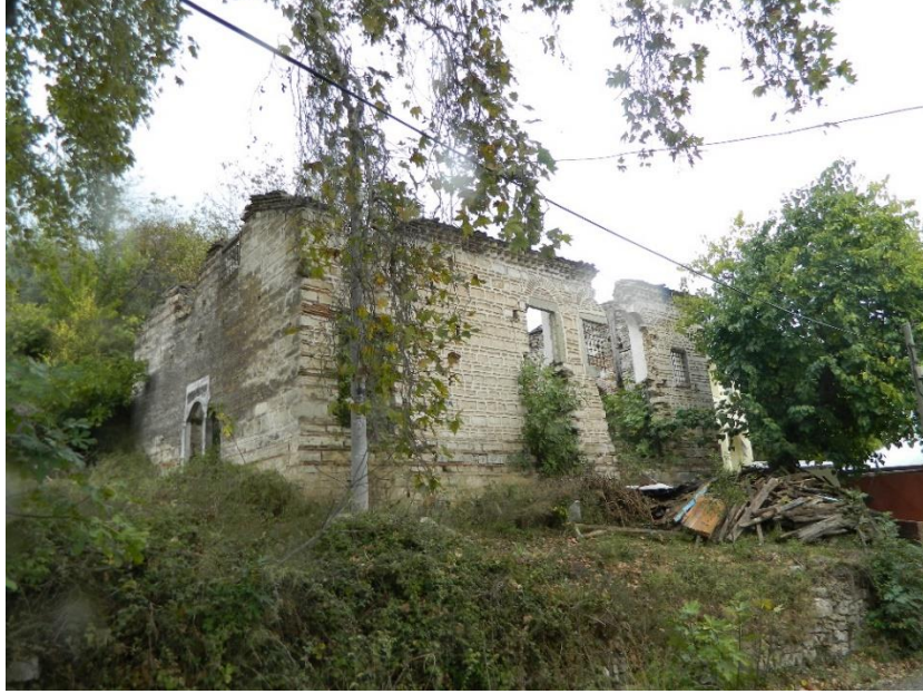
Şekil 8: Hagios Georgios Kilisesi güneybatıdan genel görünüm
