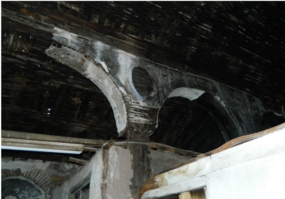
Şekil 5: Hagios Taxiarchos Kilisesi içten kuzeydoğuya bakış
