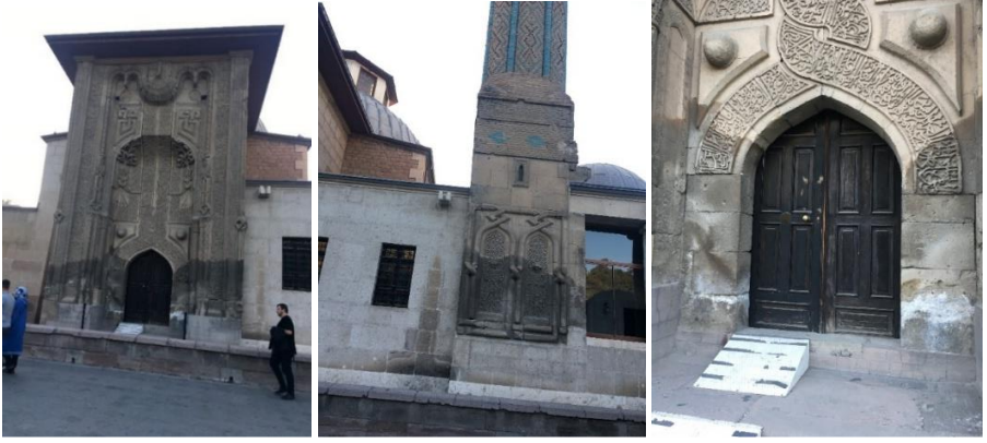
Foto 4: Medresenin taç kapısında ve minare kaidesinde nem kaynaklı renk değişimi
