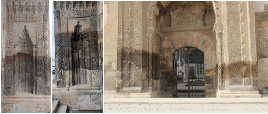
Foto 1: Taç kapı mihrabiyelerinde ve taç kapıda nem kaynaklı renk değişimleri
