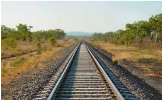
Şekil1-Balastlı Üstyapı
