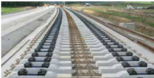
Şekil2-Balastsız Üstyapı
