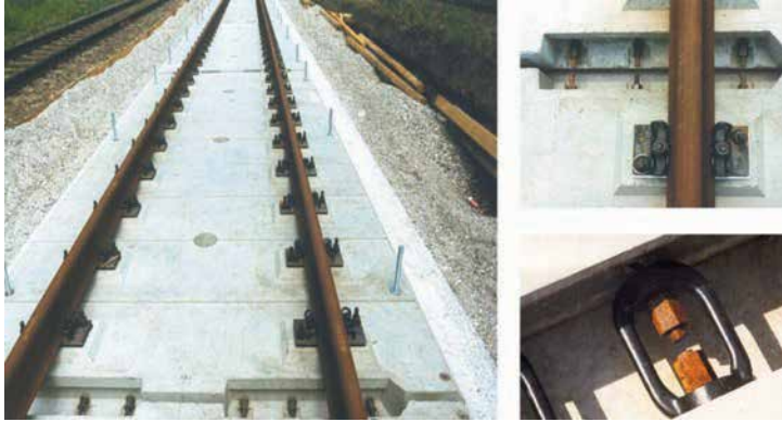
Şekil3- Beton Taşıyıcı Tabaka
