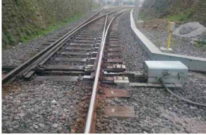
Şekil 2.3. MD2000 Makas motoru
