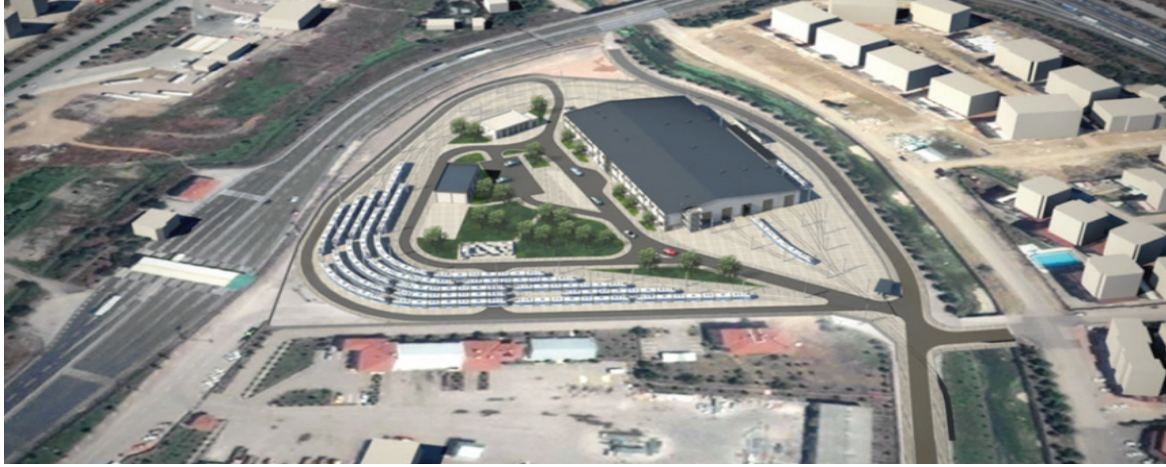
Şekil 10 : Akçaray Depo Sahası ve Atölye Binası
