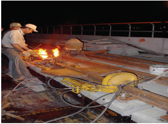
Resim 3 İstanbul Ulaşım A.Ş. (2008) Yenibosna - Havalimanı arasında LRT hattında gerilim alma çalışması
