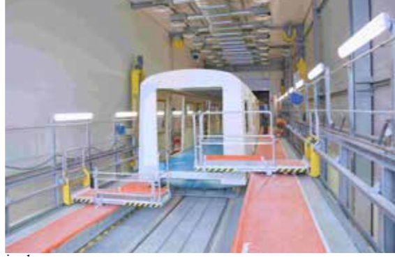
Özel mastikleme/macunlama-zımparalama-kabini, podestler ve özel personel-platformları ile, kabin içerisinde işleme tabi tutulan bir raylı taşıt aracının vagon gövdesi görülmekte.
