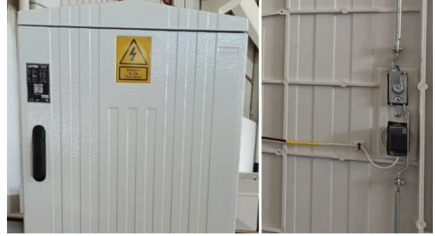
Şekil 2: Elektromekanik Kilit Sistemine Sahip Akıllı Pano Dış Görünümü ve İç Mekanizması.
