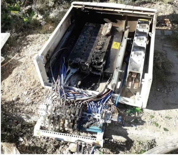
Şekil 1: Sabotaj Girişimi Sonucu Tahrip Edilen ASOP.
