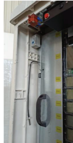
Şekil 3: Akıllı Pano İç Yapısında Sensör Entegrasyonu.
