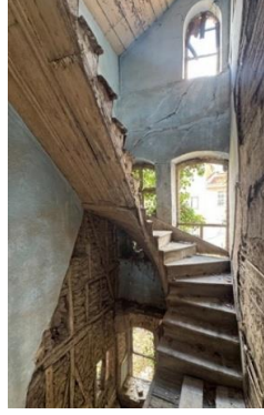
Fotoğraf 21: İkinci kata geçişi sağlayan ahşap merdiven
