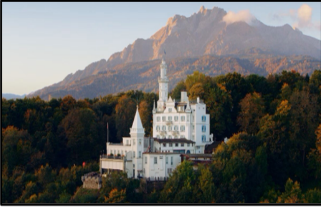
Şekil 1. Château Gütsch, İsviçre, Luzern [16]
