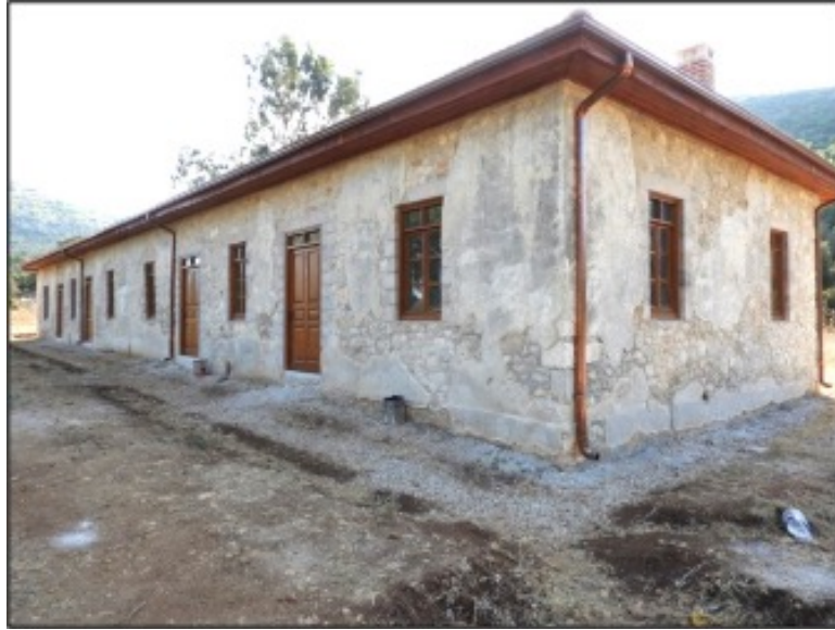
Görsel 14. Gelemiş/Patara Telsiz Telgraf İstasyonu lojman binası restorasyondan sonra.
