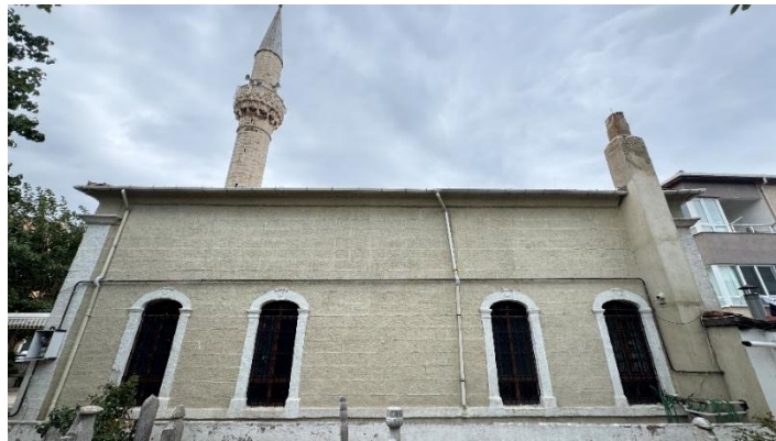
Görsel 14. Caminin güney cephesi
