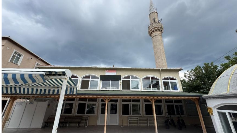
Görsel 10. Caminin kuzey cephesi
