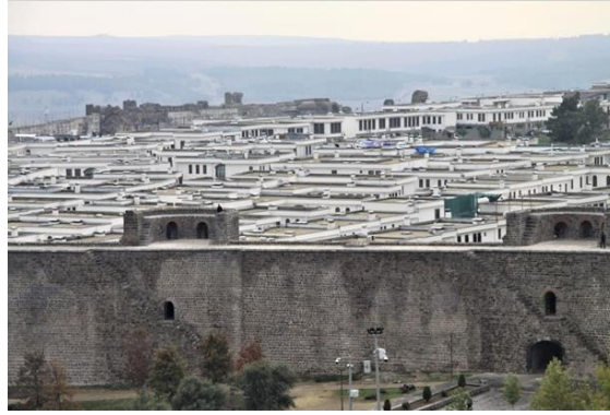
Görsel 4. Kúpeli Kapısı'nın Güney-Doğusundaki Yeni Yapılaşmanın Genel Görünümü, Diyarbakır,Suriçi, (I.C.O.M.O.S, 2022, s. 43).
