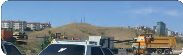
Fotoğraf 12 - Etlik'teki C tepeciğinin güneydoğusundaki İvedik caddesinden, başlatılmış olan inşaat alanı ile görünüşü (fotoğraf yazar tarafından Aralık 2015'de çekilmiştir) / The hill C in Etlik seen within the recent construction site from İvedik street on its southeast (photograph taken by the author in December 2015)
