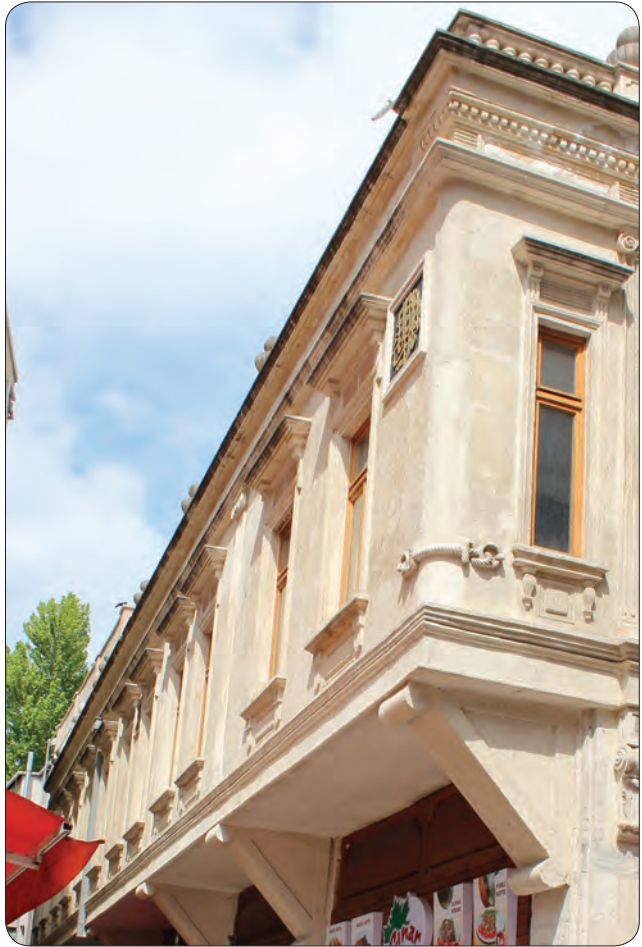
Fotoğraf 7 - Muhsinzade Hanı, batı cephe / Muhsinzade Khan west facade
