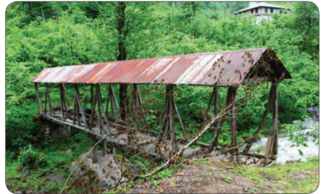
Fotoğraf 9 - Giresun Lapa Köyü Ahmet Ağa Köprüsü menba (doğu) cephe / Ahmet Ağa Bridge upstream (east) side at Lapa Village in Giresun
