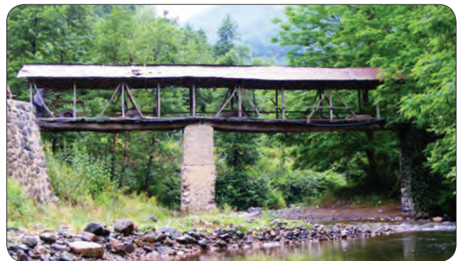
Fotoğraf 20 - Giresun Uzkara-Sayca Köyleri sınırında Ezirkan (Dillioğlu) Köprüsü güney (mansab) cephe / Ezirkan (Dillioğlu) Bridge south (downstream) facade at the borders of Uzkara-Sayca Villages (Giresun)
