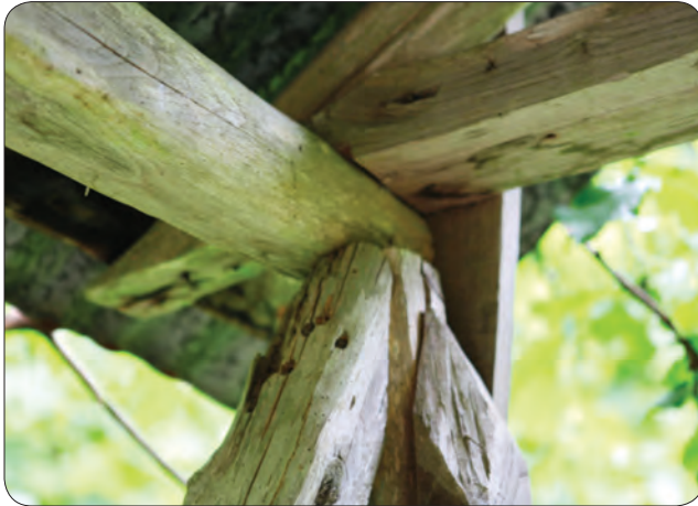
Fotoğraf 16 - Giresun Lapa Köyü Ahmet Ağa Köprüsü çatı detayı / Ahmet Ağa Bridge roof detail at Lapa Village in Giresun
