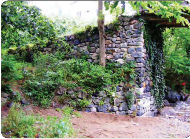
Fotoğraf 22 - Giresun Uzkara-Sayca Köyleri sınırında Ezirkan (Dillioğlu) Köprüsü ayağı doğu taraf, kuzeyden / Ezirkan (Dillioğlu) Bridge abutment east side (northerly) at the borders of Uzkara-Sayca Villages (Giresun)
