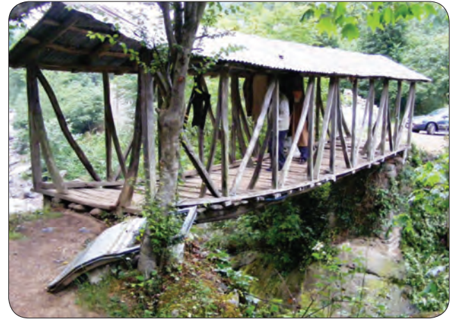
Fotoğraf 1 - Giresun Hisargeriş-Sayca Köyleri sınırında Han Köprüsü güney ve doğu (menba) cepheler / Han Bridge south and east (upstream) facades at the borders of Hisargeriş – Sayca Villages (Giresun)
