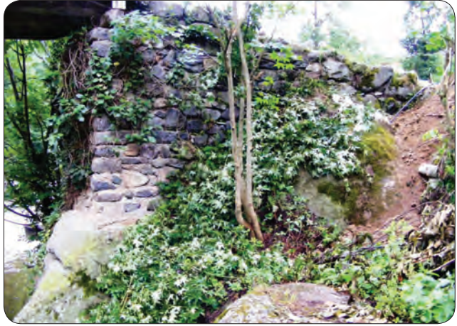
Fotoğraf 3 - Giresun Hisarçeriş-Sayca Köyleri sınırında Han Köprüsü ayağı (kuzey taraf doğu yüz) / Han Bridge foot (the north side of the east side) at the borders of Hisarçeriş – Sayca Villages (Giresun)
