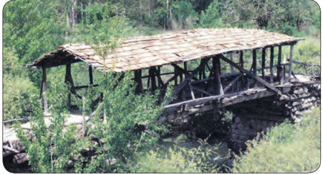
Fotoğraf 32 - Çankırı - Bayramören Yurtpınar Köyü (Şıhlar) Köprüsü (Şahin vd. 2014) / Yurtpınar (Şıhlar) Bridge at Yurtpınar Village in Bayramören – Çankırı (Şahin et.al. 2014)
