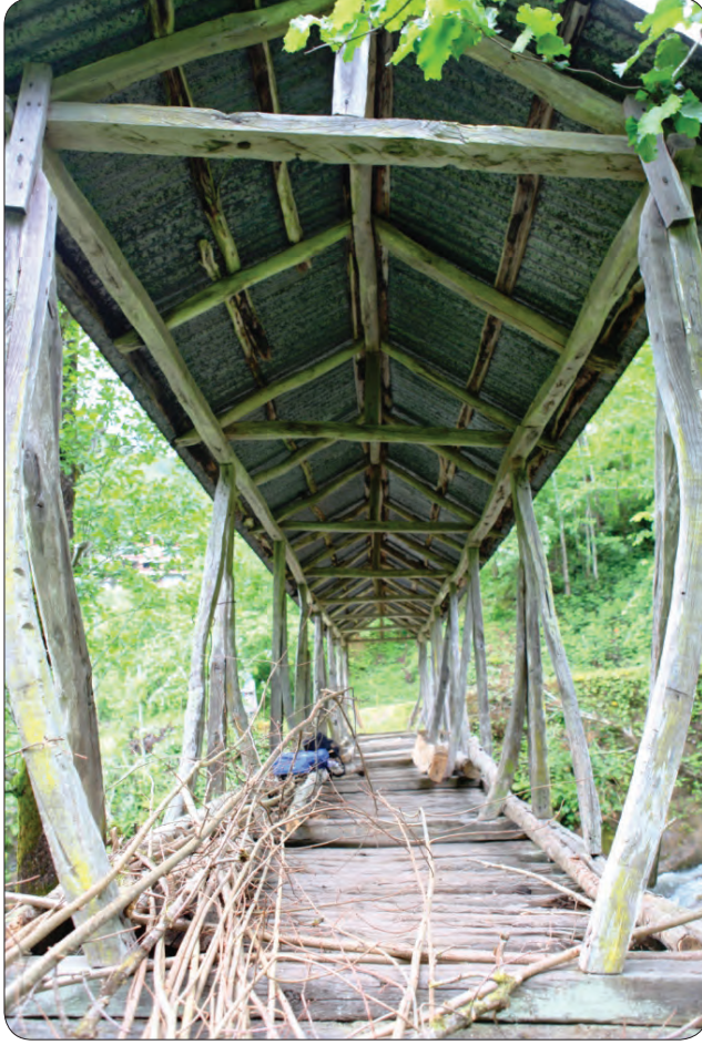
Fotoğraf 15 - Giresun Lapa Köyü Ahmet Ağa Köprüsü güneyden / Ahmet Ağa Bridge south at Lapa Village in Giresun
