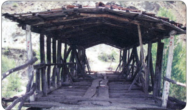
Fotoğraf 33 - Çankırı - Çerkeş Çaylı Köyü Ahşap (Çaylı) Köprü (Şahin vd. 2014) / Wooden (Çaylı) Bridge at Çaylı Village in Çerkeş – Çankırı (Şahin et.al. 2014)
