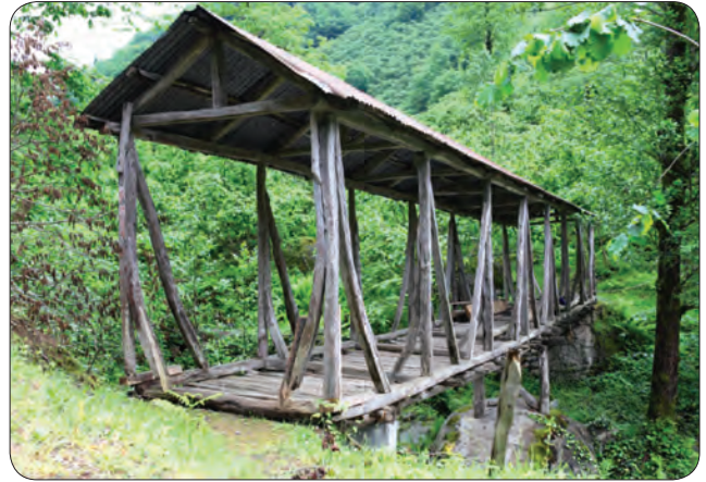
Fotoğraf 13 - Giresun Lapa Köyü Ahmet Ağa Köprüsü kuzey ve batı (mansab) cepheler / Ahmet Ağa Bridge north and west (downstream) facades at Lapa Village in Giresun
