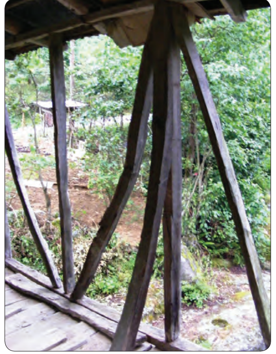
Fotoğraf 7 - Giresun Hisargeriş – Sayca Köyleri sınırında Han Köprüsü direk ve payandalar / Han Bridge pillars and supports at the borders of Hisargeriş – Sayca Villages (Giresun)
