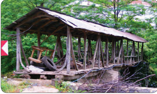
Fotoğraf 21 - Giresun Uzkara-Sayca Köyleri sınırında Ezirkan (Dillioğlu) Köprüsü batı ve güney (mansab) cephe / Ezirkan (Dillioğlu) Bridge west and south (downstream) facades at the borders of Uzkara-Sayca Villages (Giresun)
