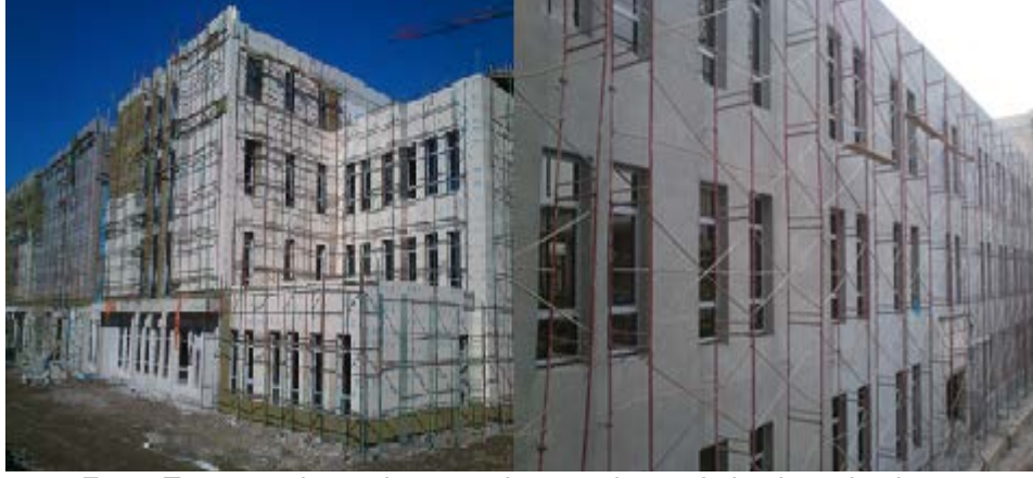
Fot.2: Taş yünü dış cephe mantolama ve kompakt laminant kaplama (Prokon&Beşer Ortaklığı, 2012).
