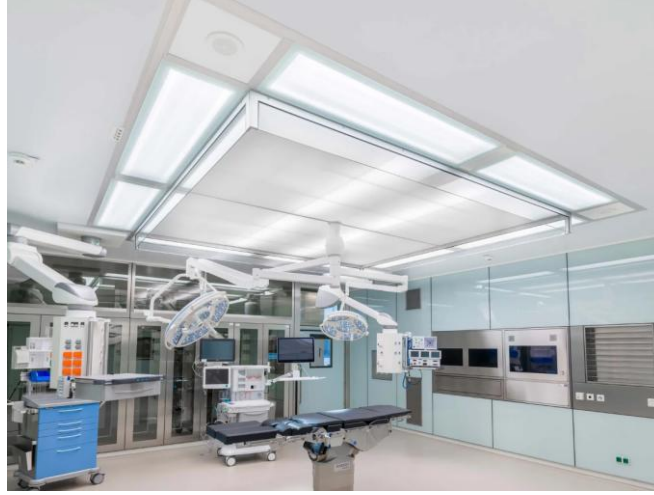
Şekil 4: Ameliyathanelerde en yüksek hava temizliği için kullanılan HEPA filtreli tavan panelleri. (URL-2)
