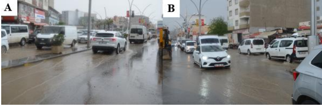
Şekil 13. A ve B) Selden Sonra Cizre-Silopi Ana Karayolunun Durumu
