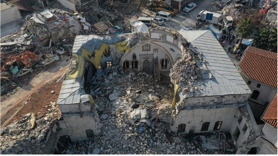
Resim 3: Antakya Habib en-Neccar Camii'nin 06.02.2023 Kahramanmaraş Merkezli Deprem Sonrası Genel Görünümü (AA Arşivi, 2023)
