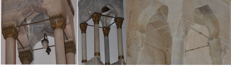
Resim 41: Habib en-Neccar Camii, Yeni Camii ve Mahremiye Camii Minber Köşkü Sütunce Başlığındaki Mukarnas Detaylar (Soldan Sağa)
