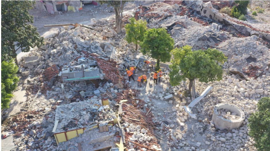
Resim 2: Antakya Ulu Camii'nin deprem sonrası enkaz görünümü (rhaajans arşivi, 2023)
