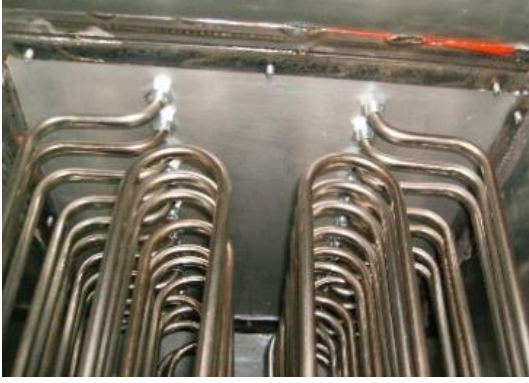
Şekil 2. Hava ısıtıcı elektrik rezistansları
