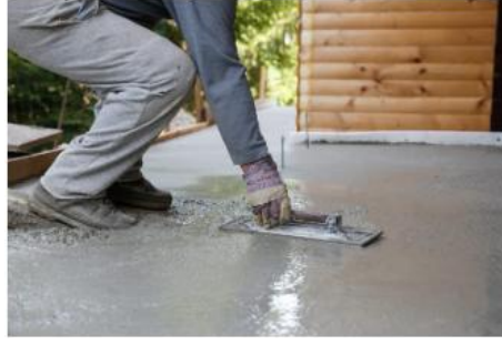
Şekil 6. Taze Betonun Düzleştirme İşlemi Yapan Bir Çalışan
