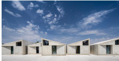
Şekil 2. Prefabrik Sistemlerle Üretilmiş Bir Yapı Örneği
