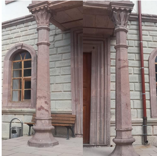
Görsel 11. Güney Cephedeki Cumbayı Taşıyan Sol ve Sağ Sütun
