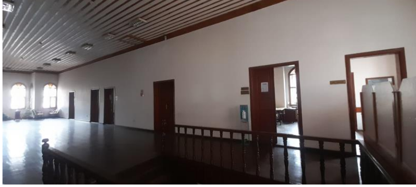
Görsel 19. İkinci Katta Kuzey Cephedeki Oda ve Dersliklerin Genel Görünümü
