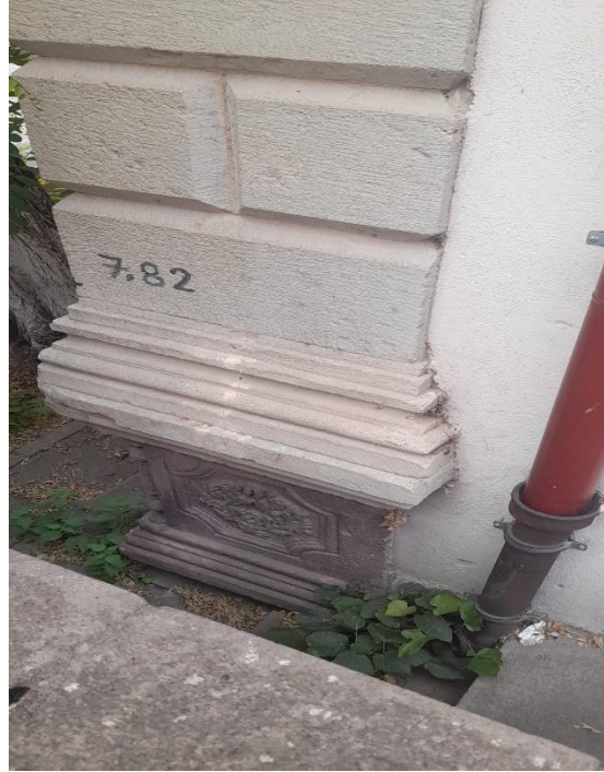
Görsel 7. Doğu Cephesi Genel Görünüm
