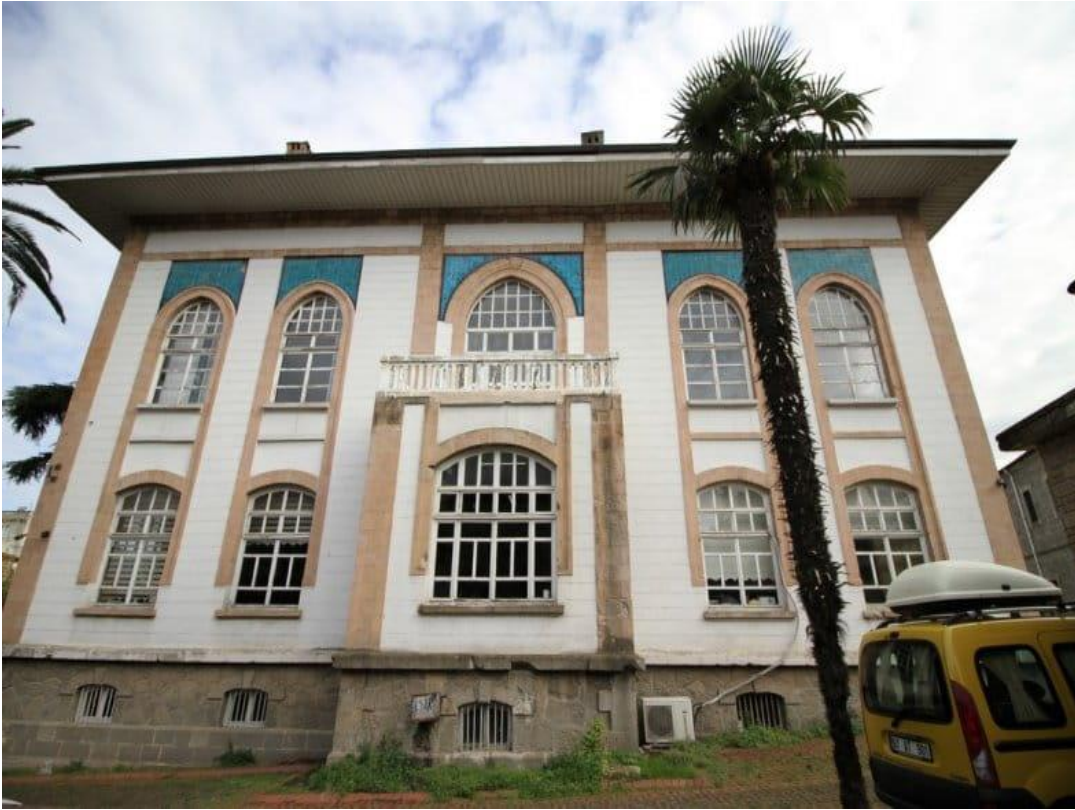
Görsel 25. Trabzon/Ortahisar Eski Hükümet Konağı (www.https://karadeniz.gov.tr)
