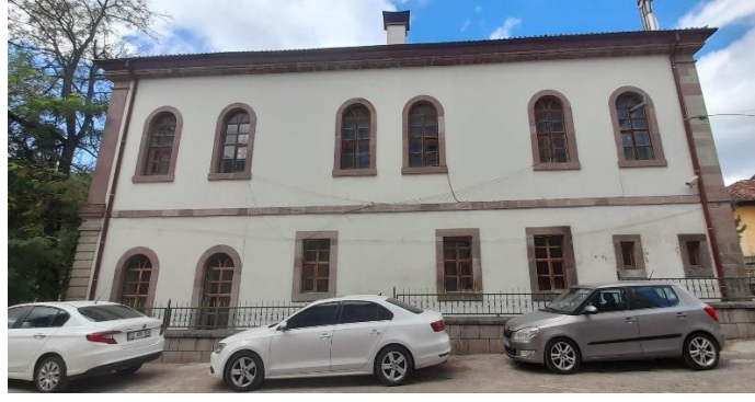
Görsel 6. Doğu Cephesi Genel Görünüm
