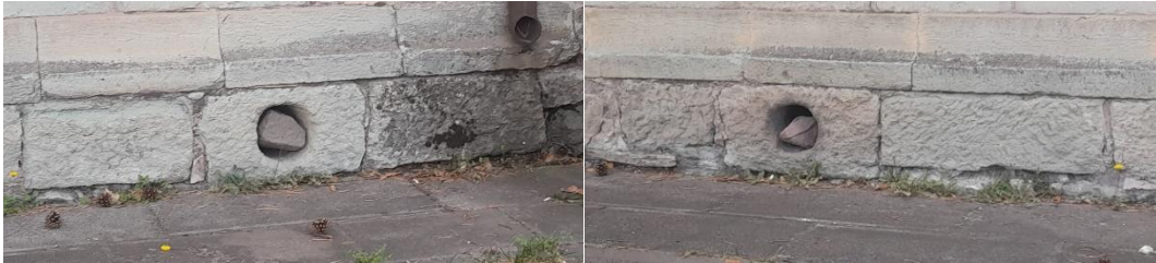
Görsel 13. Batı Cephesindeki Havalandırma Deliklerinden
