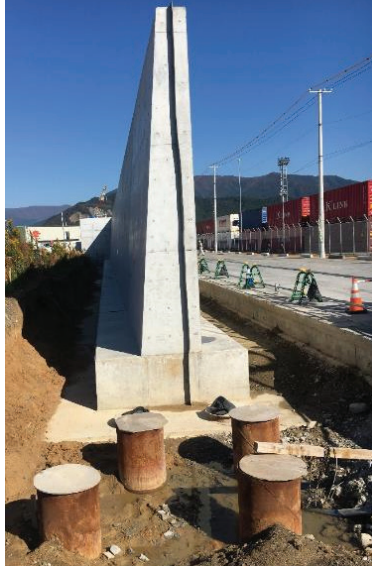
Fotoğraf 4. Ofunato Limanı Kıyı Duvarları Yapımı (Tarih: Ekim, 2016)
