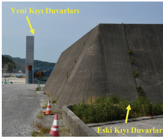
Fotoğraf 8. Yamada Şehri Eski ve Yeni Kıyı Duvarları (Tarih: Haziran, 2016)
