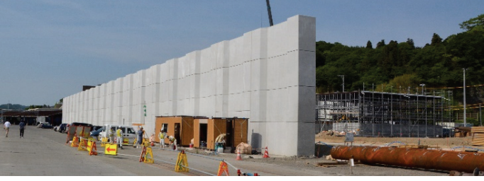
Fotoğraf 6. Miyako Şehri Kıyı Duvarları (Tarih: Haziran, 2016)
