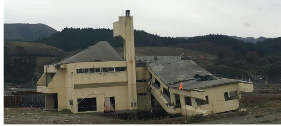
(b) Enkazı Yerde Bırakılan Betonarme Bina
