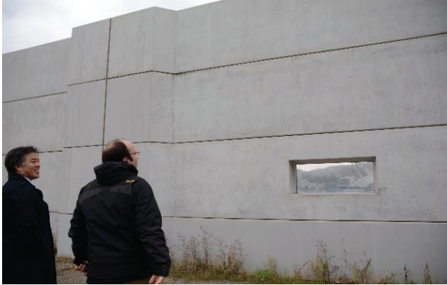
Fotoğraf 5. Kesennuma Limanı Kıyı Duvarları (Tarih: Ekim, 2016)
