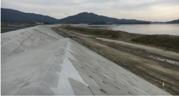
Fotoğraf 14. Rikuzentakata Kıyı Tahkimatı (Tarih: Ekim, 2016)
