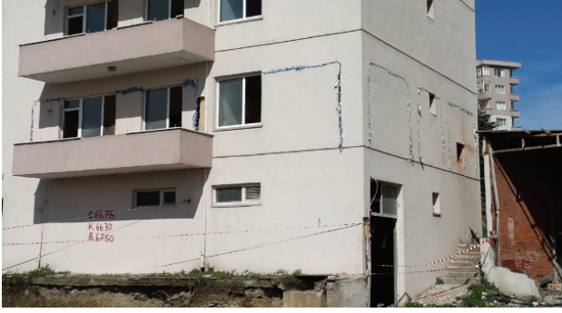
Şekil 9. Duvar ayırma işlemi sonrası yapının dışarıdan görünüşü
