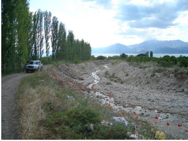
Fotoğraf 1: 50 m. lik muhtemel taşkın etki mesafesine göre hazırlanması planlanan taşkın koruma yapısı projesi alanından görünüm (Gelendost):
