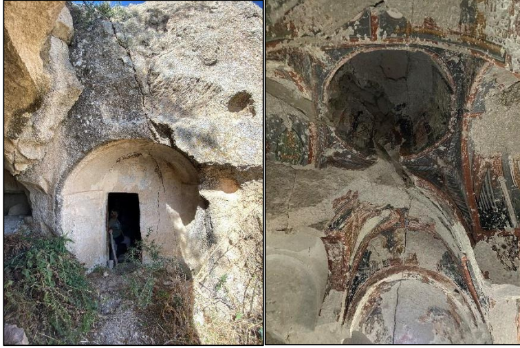
Şekil 10. Karlık Kilisesi Girişi ve Naos Kubbesi (Dırık, 2024)
