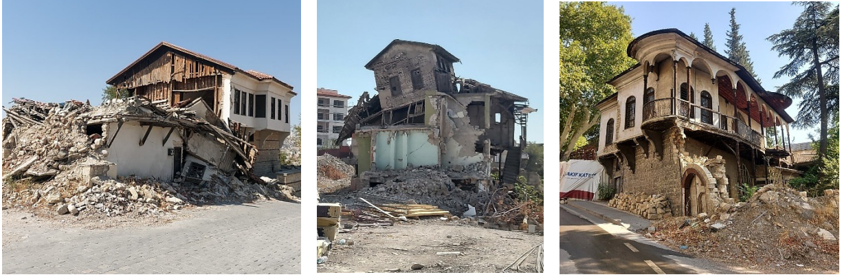
Şekil 4: Tescilli taşınmaz sivil mimarlık eserlerinin Ağustos 2025 tarihindeki durumlarına örnekler (Fotoğraflar, Esra Abacıoğlu Gitmiş tarafından çekilmiştir)
