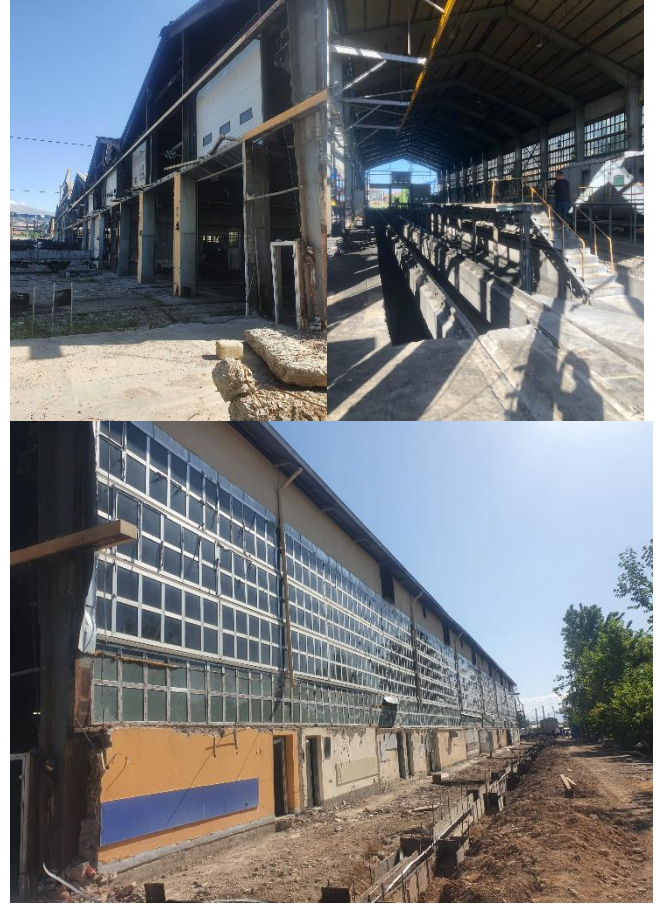
Şekil 4. İstasyon binasından kareler.
