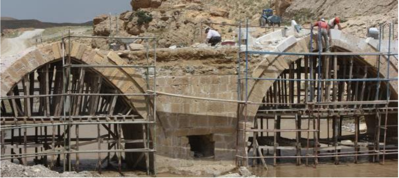
Şekil 23. Kelekom Köprüsü memba cephe onarım görünüşü (Fotoğraf yazarlar tarafından 2011 yılında çekilmiştir.)
