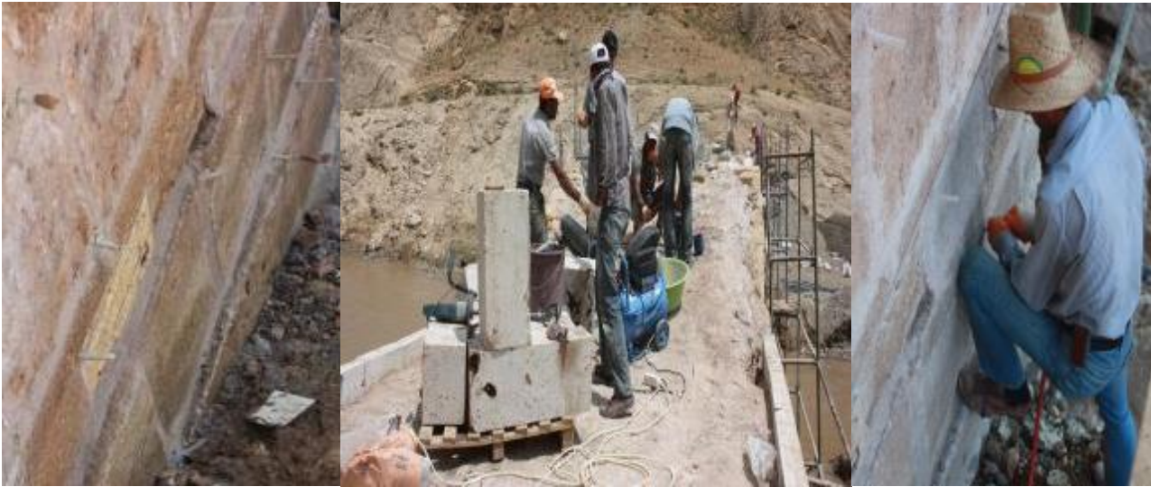
Şekil 22. Kelekom Köprüsü cephe ve döşeme enjeksiyon onarım uygulama görüşleri (Fotoğraflar yazarlar tarafından 2011 yılında çekilmiştir.)
