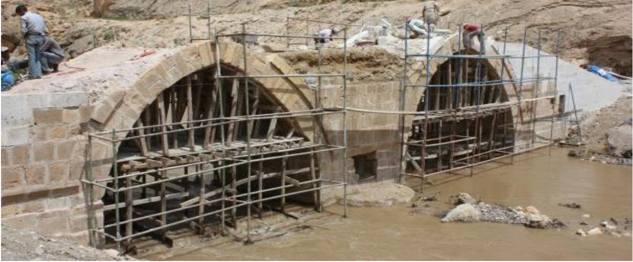
Şekil 20. Kelekom Köprüsü mansap cephe onarım görünüş (Fotoğraf yazarlar tarafından 2011 yılında çekilmiştir.)
