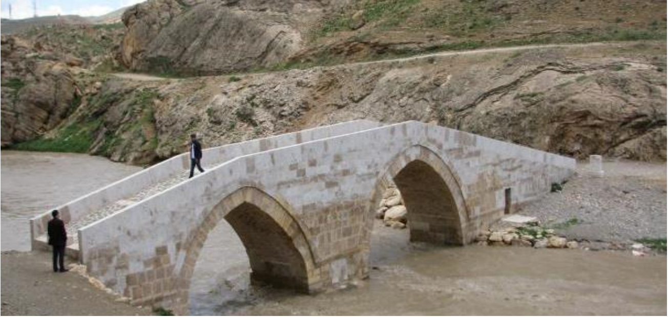
Şekil 16. Kelekom Köprüsü mansap genel görünüşü (Fotoğraf yazarlar tarafından 2023 yılında çekilmiştir.)
