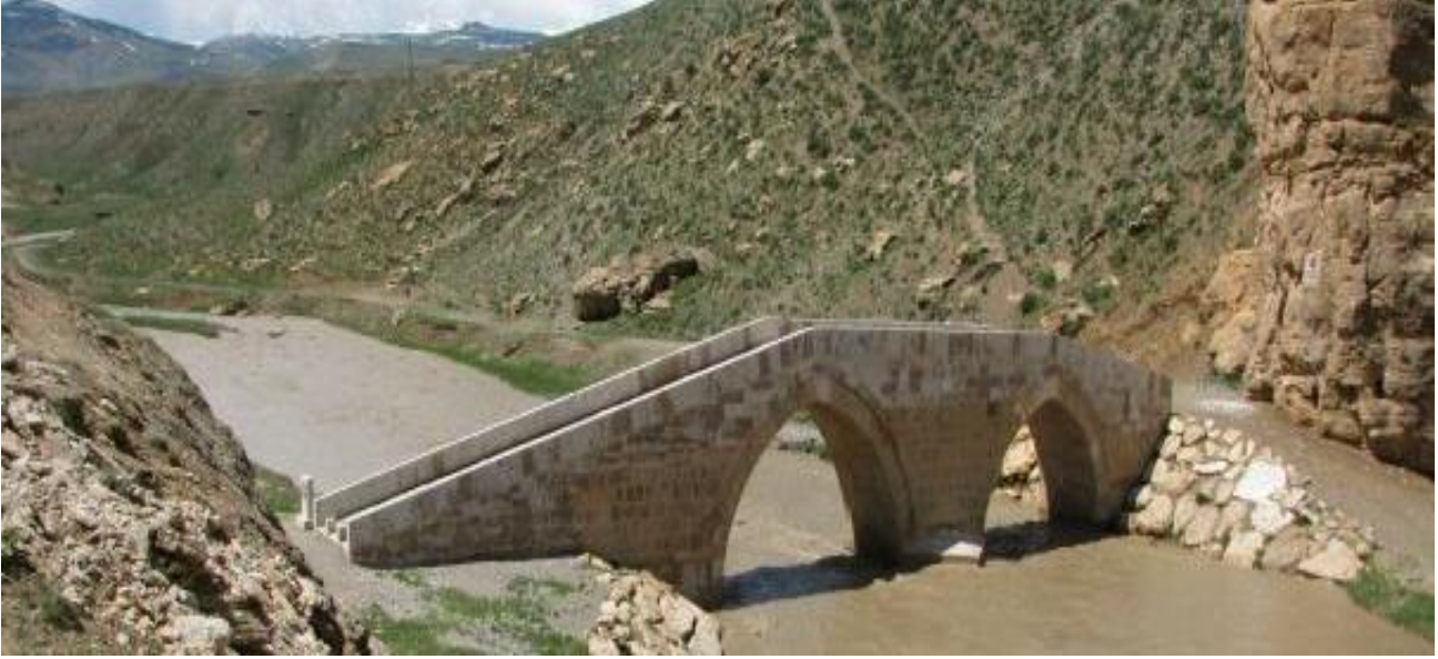
Şekil 14. Kelekom Köprüsü memba genel görünüşü (Fotoğraf yazarlar tarafından 2023 yılında çekilmiştir.)
