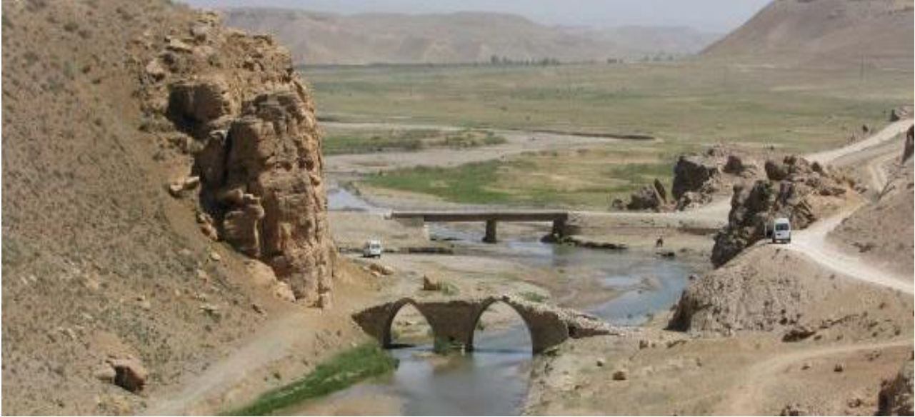
Şekil 4. Kelekom Köprüsü mansap genel görünüşü (Fotoğraf yazarlar tarafından 2010 yılında çekilmiştir.)
