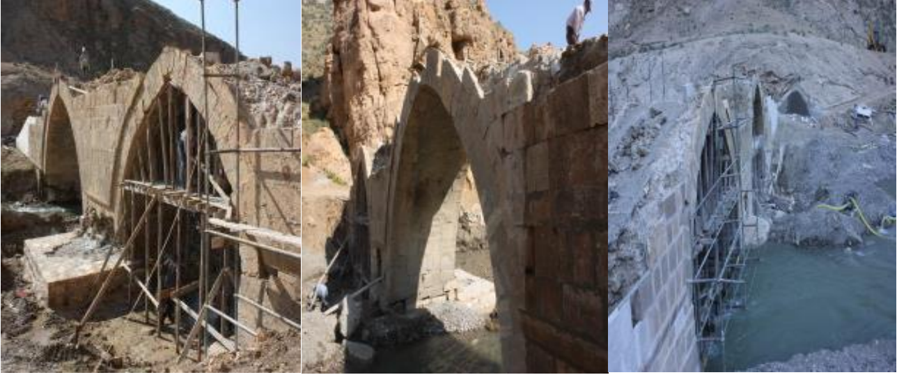
Şekil 21. Kelekom Köprüsü cephe onarım görüşleri (Fotoğraflar yazarlar tarafından 2011 yılında çekilmiştir.)
