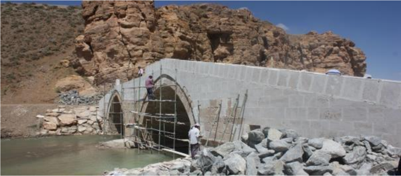
Şekil 26. Kelekom Köprüsü mansap cephe onarım görüşü (Fotoğraf yazarlar tarafından 2011 yılında çekilmiştir.)
