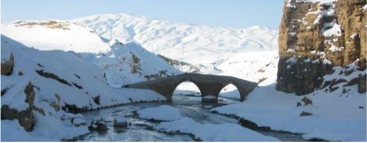
Şekil 7. Kelekom Köprüsü memba genel görünüşü (Fotoğraf yazarlar tarafından 2020 yılında çekilmiştir.)
