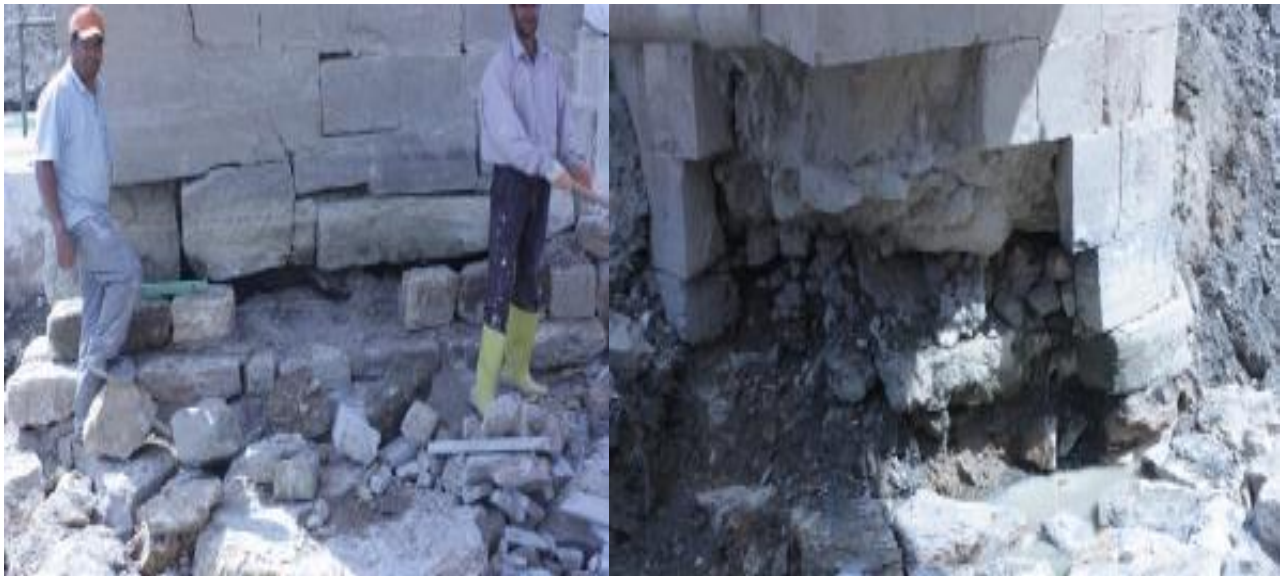
Şekil 24. Kelekom Köprüsü temel ayak onarım görünüşleri (Fotoğraflar yazarlar tarafından 2011 yılında çekilmiştir.)
