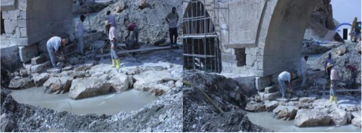
Şekil 27. Kelekom Köprüsü çığlı deresi köprü yatağı moloz taş tahkimat görünüşleri (Fotoğraflar yazarlar tarafından 2011 yılında çekilmiştir.)
