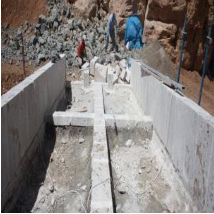
Şekil 18. Kelekom Köprüsü döşeme taş kaplama görünüşleri (Fotoğraf yazarlar tarafından 2011 yılında çekilmiştir.)
