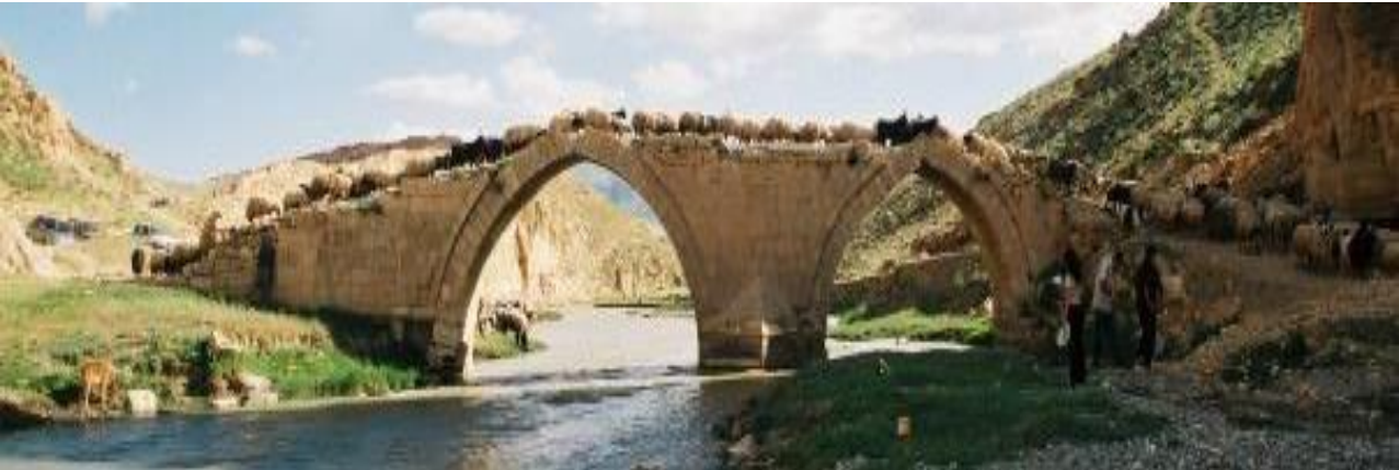
Şekil 6. Kelekom Köprüsü memba genel görünüşleri (Fotoğraflar yazarlar tarafından 2007 yılında çekilmiştir.)
