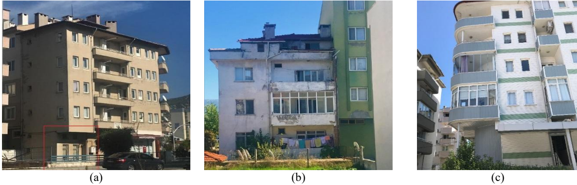
Şekil 3. Muğla, Emirbeyazıt mahallesinden temsili seçilen binalar, (a) Yumuşak kat, (b) Bitişik nizam, (c) Ağır çıkma
